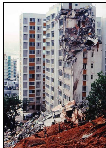
1972 年 6 月 16-18 日暴雨連場，導致嚴重山泥傾瀉，其中香港島半山區十二層高的旭龢大廈完全摧毀。（照片來源：政府新聞處）
